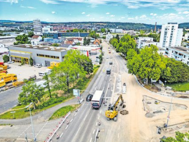
Am 16. März gibt es Informationen zum weiteren Verlauf der Bauarbeiten. Foto: Martin Kalb
