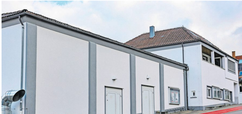
Das frühere Bissinger Kino in der Steigstraße 1.
