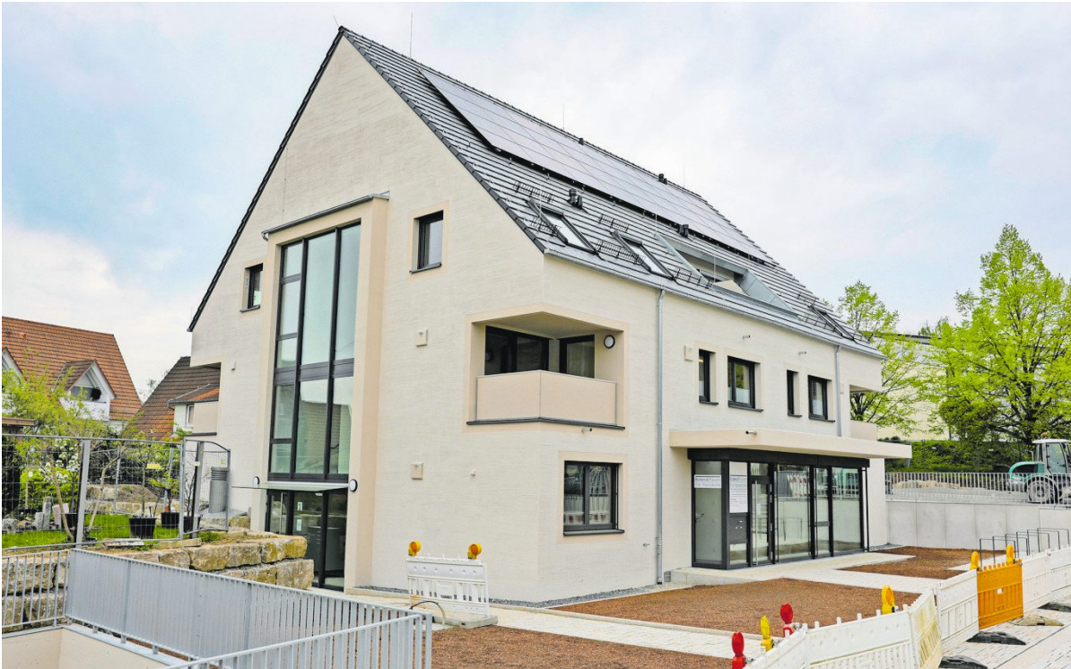
Das neue Ärztehaus in der Nonnengasse wurde von der gemeindeeigenen Immobilien- und Verwaltungs-GmbH gebaut. Es bildet die zentrale Komponente in der neuen Ortsmitte. Fotos: Martin Kalb
