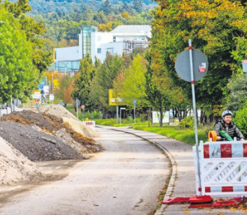
Die Bauarbeiten im Poststräßle sind endlich abgeschlossen. Archivfoto: Martin Kalb
