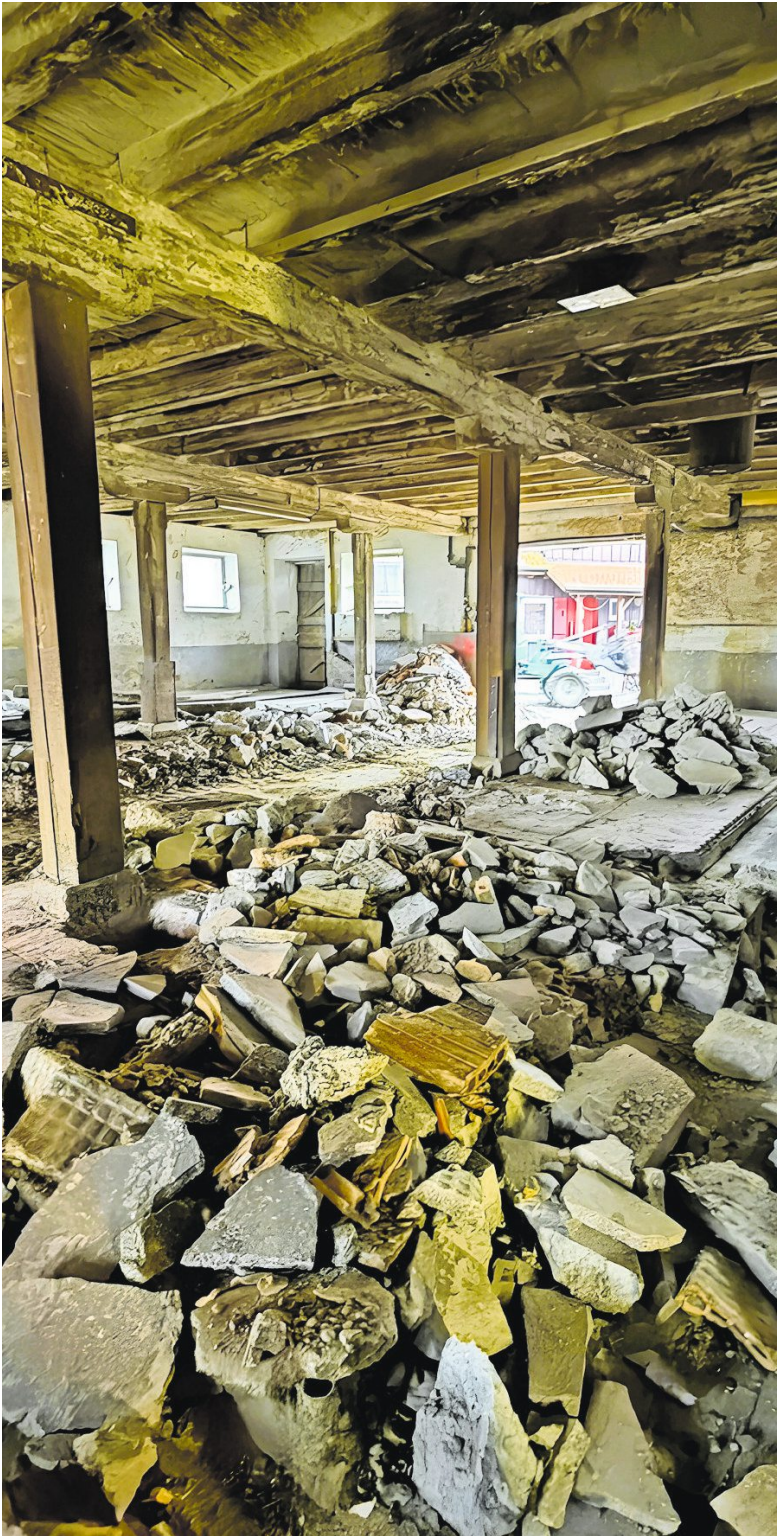
Alte Strukturen mussten freigelegt, gesichert und teilweise aufwendig erneuert werden.
