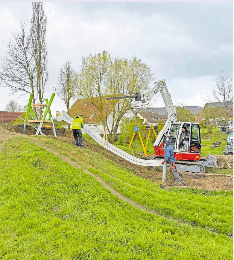
Die neue Rutsche wird gebaut. Fotos: Stadt Vaihingen
