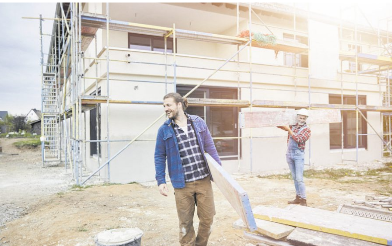
Von Suffizienz bis Eigenleistung: Wer an den wichtigen Stellschrauben dreht, kann beim Hausbau viel Geld sparen. Foto: Westend61 / MiJo
