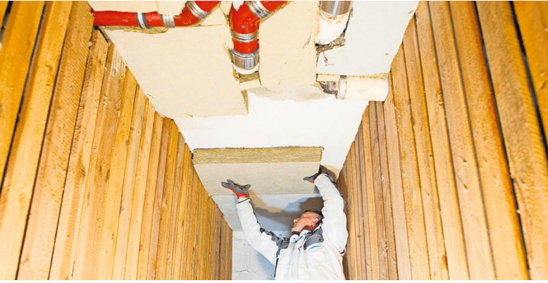
Kellerdecke dämmen, Heizkosten senken: Wer handwerkliches Geschick besitzt, kann die Dämmung der Kellerdecke selbst anbringen. Foto: Klaus-Dietmar Gabbert/dpa-mag
